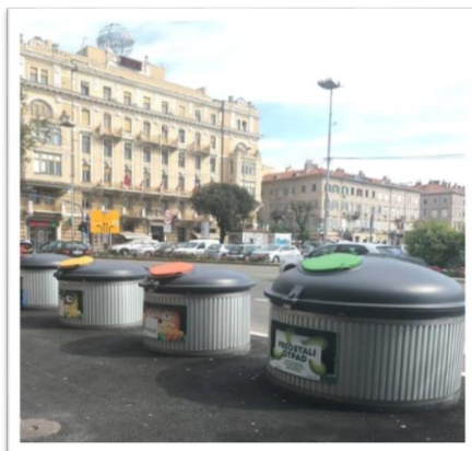
Slika 8. Poluukopani spremnici na lokaciji Riva 4
